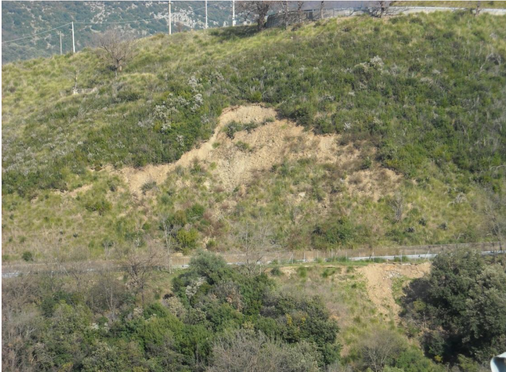
Foto n° 25 – Frana per colata rapida lungo la scarpata a monte al Km 5 della S.P. ex S.S. 104
