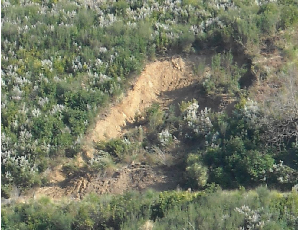
Foto n° 25 – Frana per colata rapida lungo la scarpata a monte al Km 5 della S.P. ex S.S. 104
