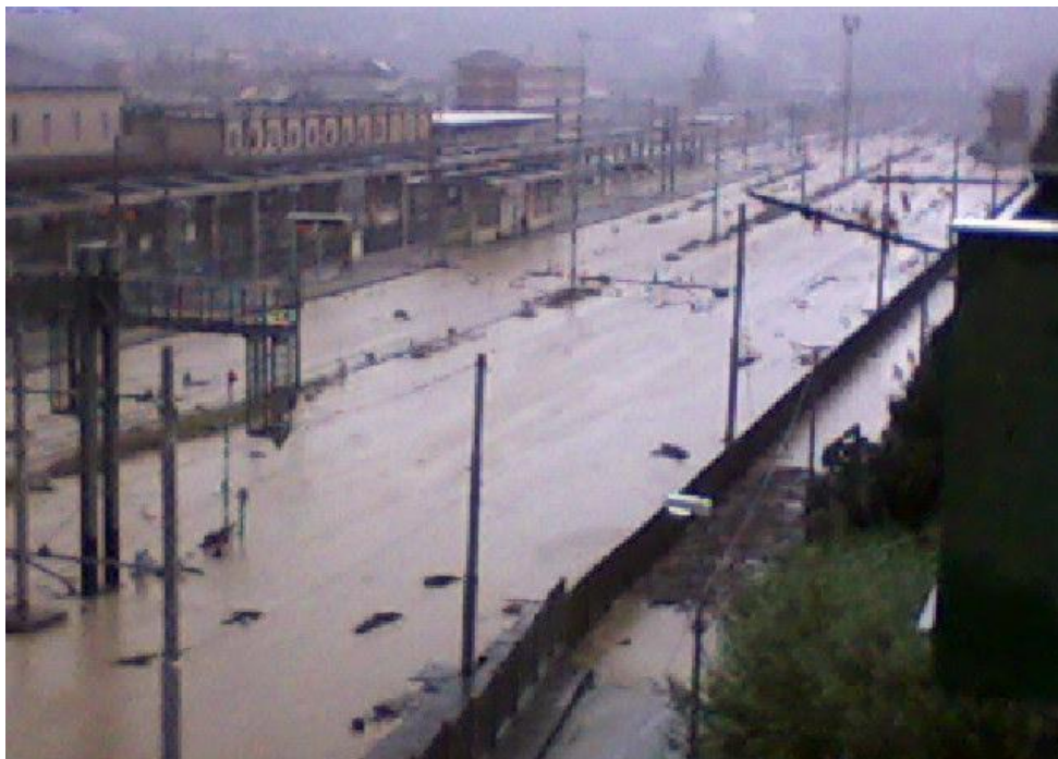
Foto n° 18 – allagamento della linea ferroviaria il 14 Ottobre 2010
