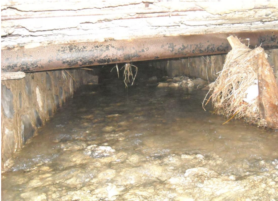
Foto n°22 – cordolo in c.a. di una rete di sottoservizi che attraversa la sezione tombata del v.ne S. Ischitello in Via Kennedy
