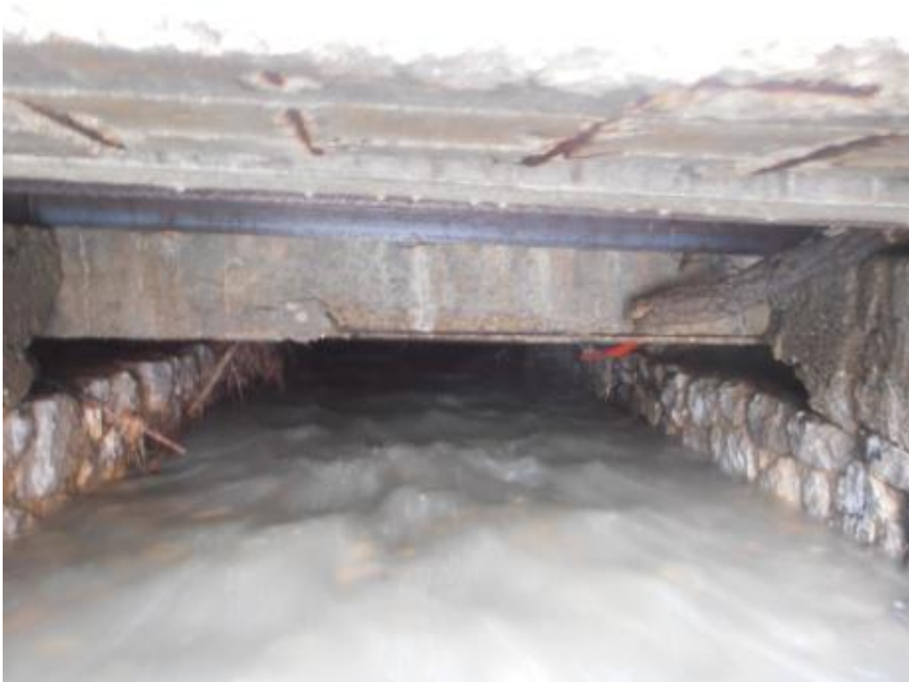
Foto n°22 – cordolo in c.a. di una rete di sottoservizi che attraversa la sezione tombata del v.ne S. Ischitello in Via Kennedy
